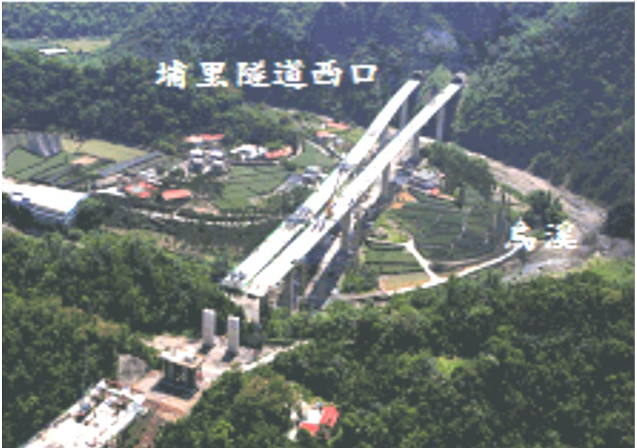
圖12 國道六號南投段橋梁與隧道銜接位置地形狀況
