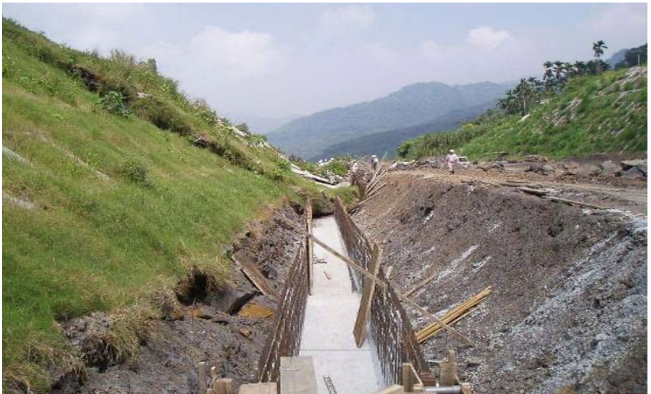
圖8 國道六號南投段路塹邊坡坡趾邊溝工程
