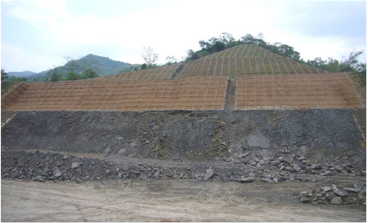
圖11 國道六號南投段路塹邊坡坍滑後邊坡保護工施工
